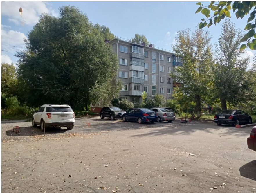
г. Омск, Октябрьский АО, в 10-20 м северо-западнее многоквартирного дома № 16А по ул. 50 лет ВЛКСМ
