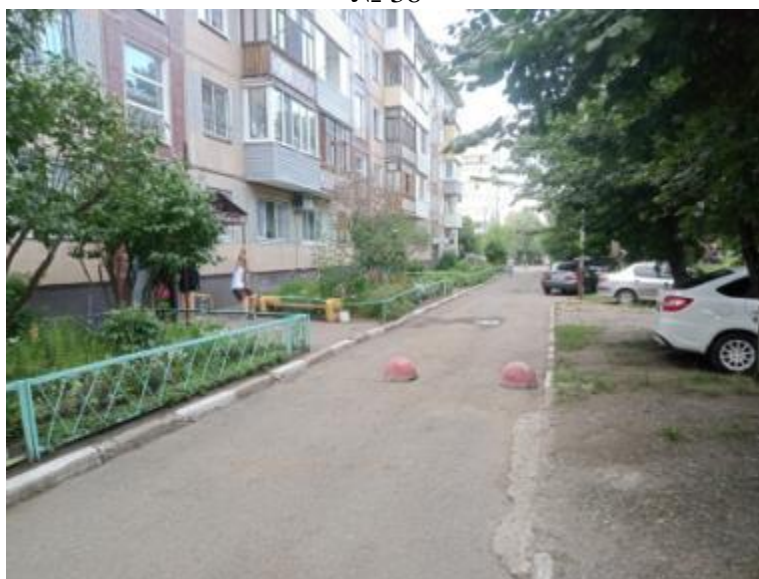
г. Омск, Кировский АО, в 5-7 м. восточнее многоквартирного дома № 3Б по ул. Путилова
