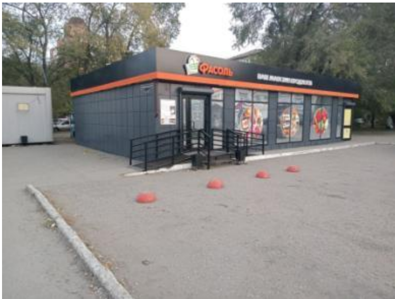
г. Омск, Центральный АО, в 20-25 м. северо-восточнее многоквартирного дома № 94 по ул. 22 Партсъезда
